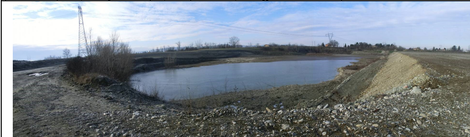
📍 Foto 2: Panoramica dell'area di cava "Fondo Siberia 2" dallo spigolo N-E. Vuoto di cava parzialmente invasato di limi di frantoio con vegetazione spontanea arboreo/arbustiva a contornare la scarpata est. Sulla destra il collegamento a raso con il piano di recupero di Cava Case Secchia.
