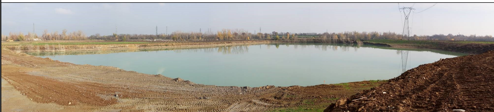
🔗 Foto 4: Panoramica dell'area di cava "Fondo Siberia 2" dal limite W. Sulla destra dello scatto si noti il collegamento del ciglio di cava all'adiacente piano di recupero della cava Fondo Siberia. Sulla sinistra la pista di cantiere, parzialmente decorticata, di accesso a Cava "Case Secchia 2".
