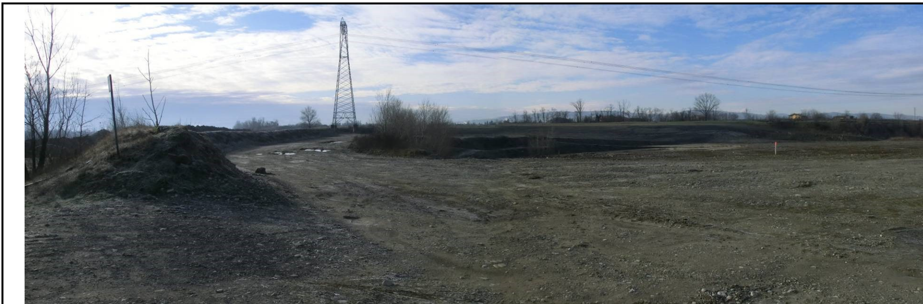
📍 Foto 1: Panoramica dell'area di cava "Fondo Siberia 2" vista dall'ingresso sul lato est. Si noti sulla sinistra l'arginatura di mitigazione di separazione con la pista perfluviale e l'ampia zona, morfologicamente in quota, ad uso pista di servizio, da assoggetta a dissodamento e ripristino del suolo di coltivo
